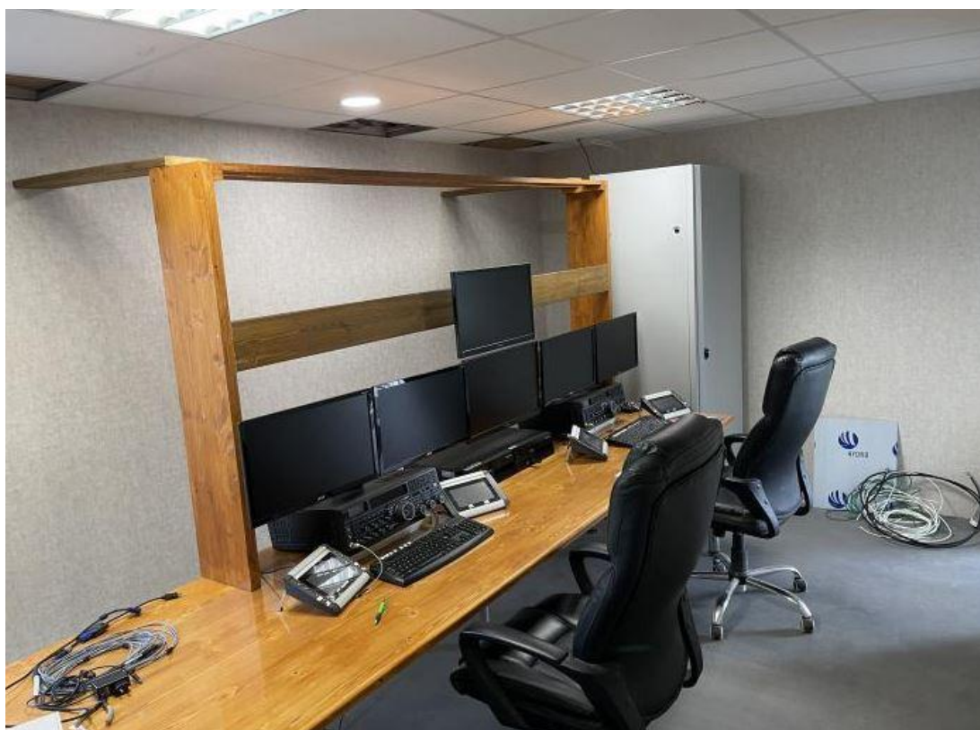
Vue partielle du nouveau local radio en construction
