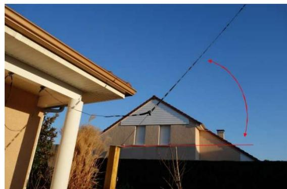
Le câble Twin-lead peut descendre sous un angle de 30 à 35 ° (pas plus) et le tendeur dynamométrique avec ressort de compensation en inox, est à définir suivant la longueur du câble; il ne doit pas excéder 10 m. Force du ressort = poids du feeder x 1,5 plus le frottement en fonction du diamètre de la poulie. A tester : ne pas trop le tendre, laisser une légère courbe au feeder. Il est autoportant et ne doit pas vriller au vent.
