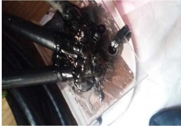
Avec la protection contre les intempéries
